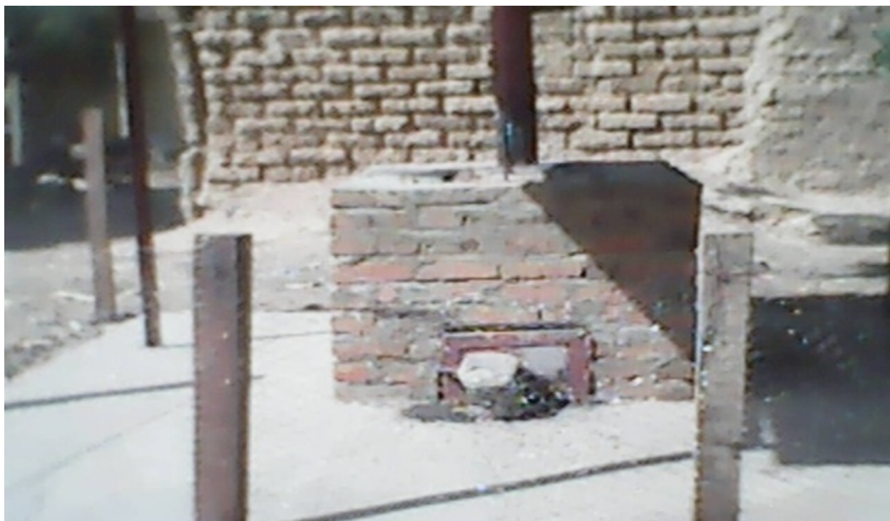
Incinérateur de Boidie de type petit Montfort en Mauvais état.
