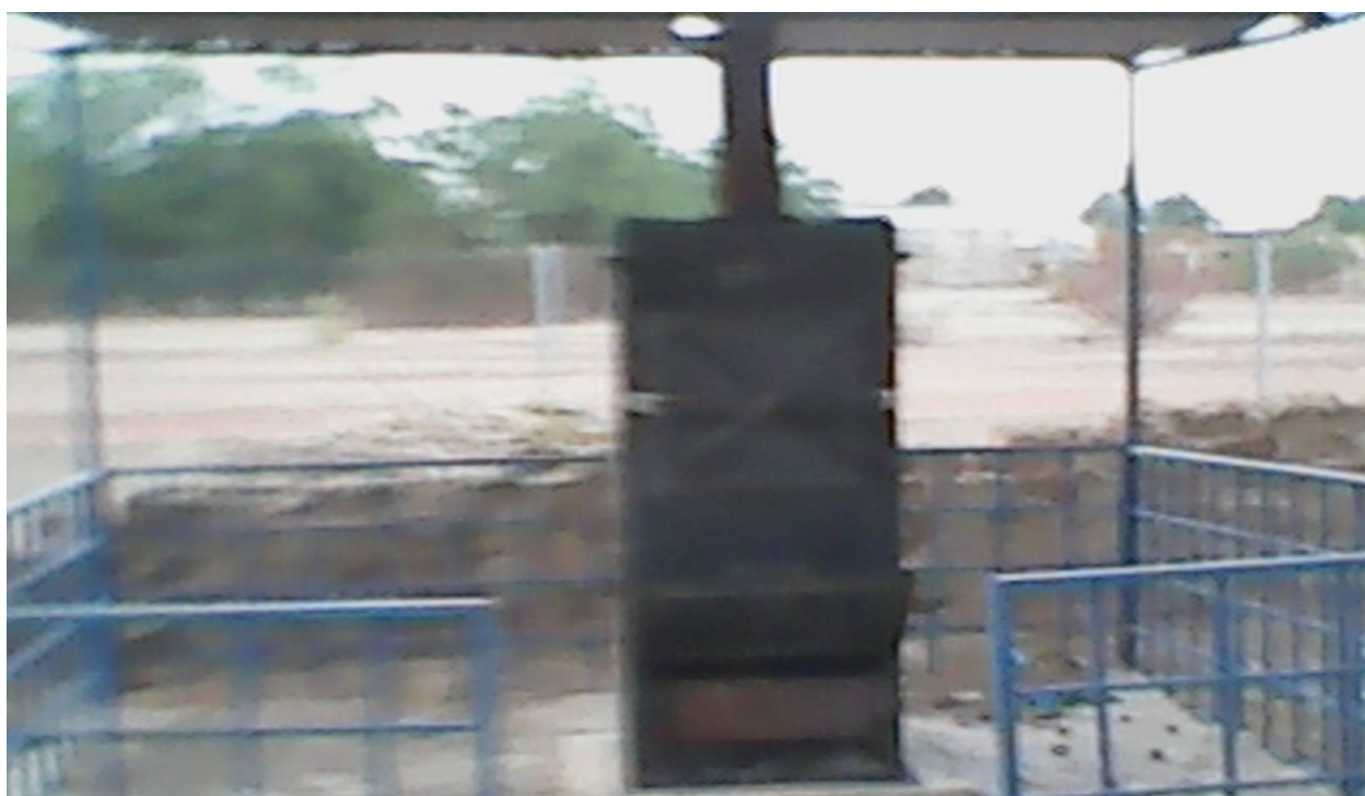
Incinérateur Sanando de type G-Dragon en bon état.
