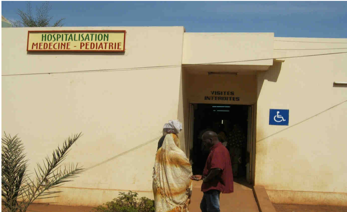
Figure 9 : vue photographique du service de pédiatrie
