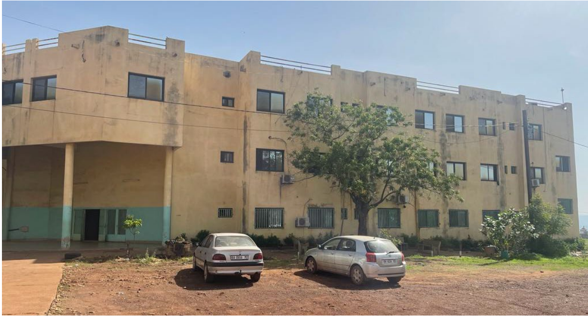
Figure 2 : vue d'ensemble de face convexe - Médecine Interne côté Sud au bord de la route
