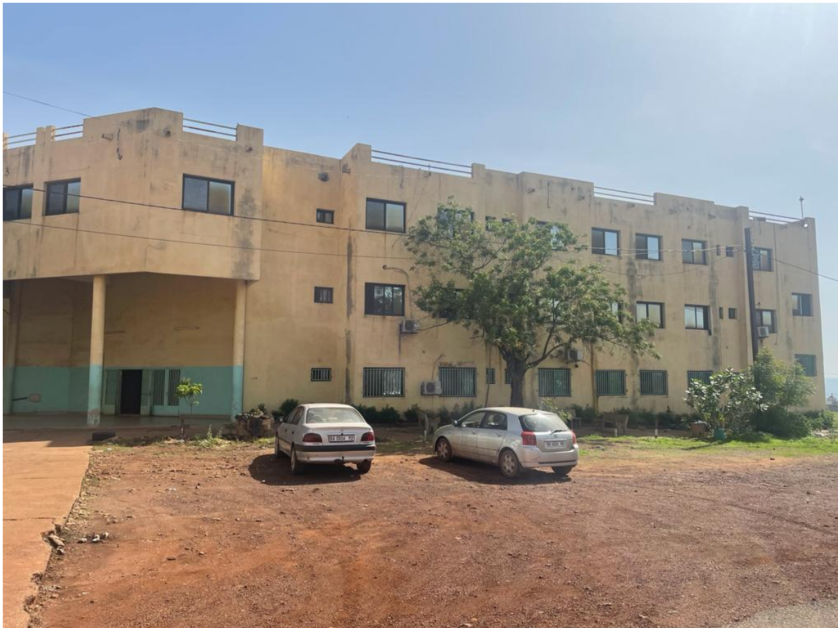
Figure 2 : vue d'ensemble de face convexe - Médecine Interne côté Sud au bord de la route
