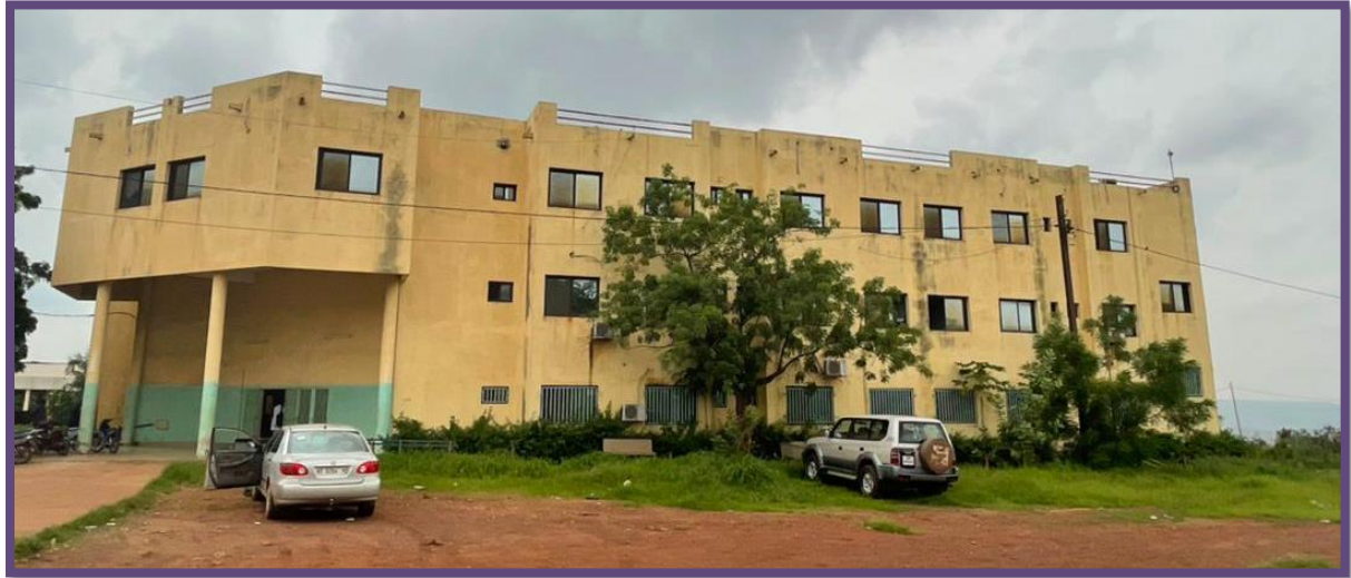
Figure 10 : Vue d'ensemble de face convexe - Médecine Interne côté Sud au bord de la route
