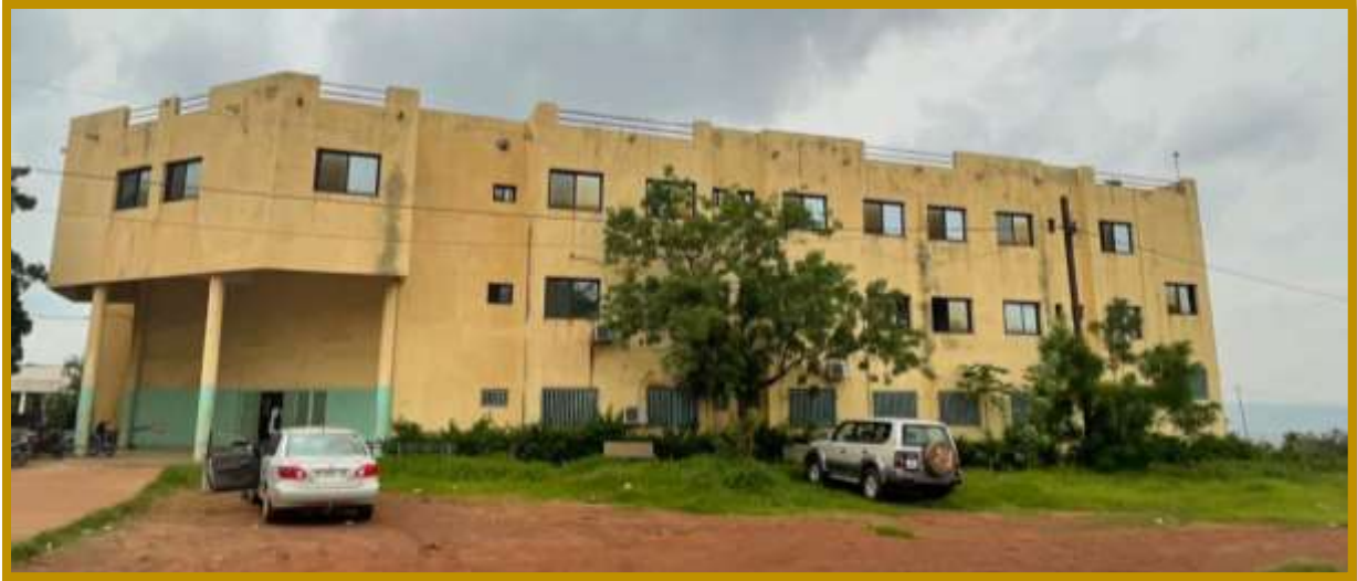
Photo 2 : Vue d'ensemble de face convexe – Médecine Interne côté sud au bord de la route
