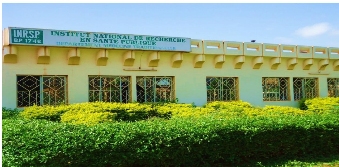
Figure 3 : Photo d'une façade du Département Médecine Traditionnelle
