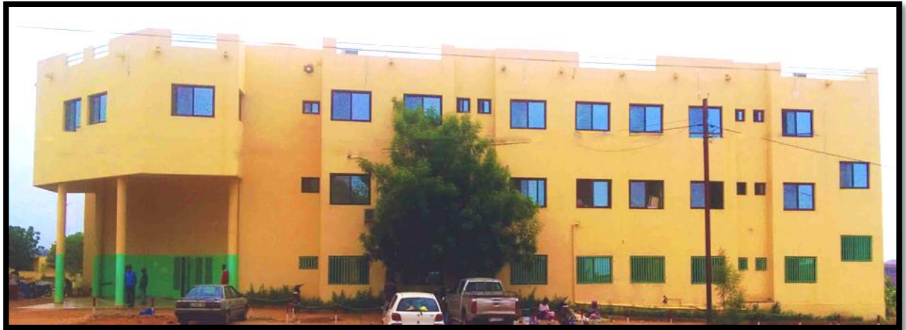
Photo 2 : Vue d'ensemble de face convexe – Médecine Interne côté sud au bord de la route
