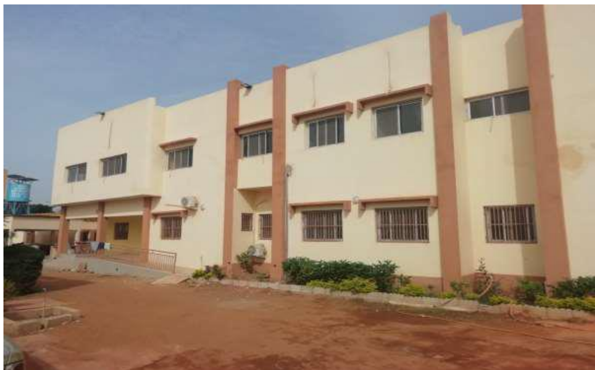
Figure 3 : Vue photographique de la façade principale du service de pédiatrie
