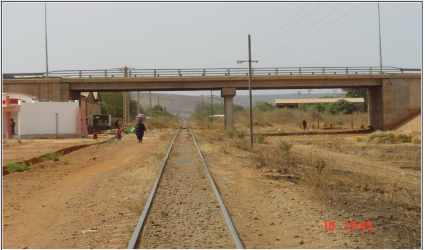
Voie ferrée Bamako-Kati passant en dessous de l'échangeur, près de l'immeuble BABEMBA à Bamako.
