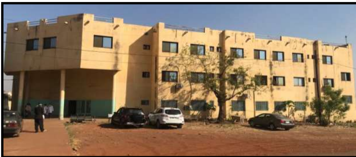
Figure 5 : Vue d'ensemble de face convexe – Médecine Interne côté sud au bord de la route
