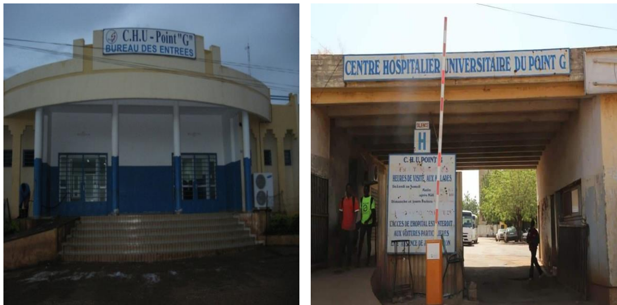
Figure 23 : Bureau des entrées du CHU du Point- G
