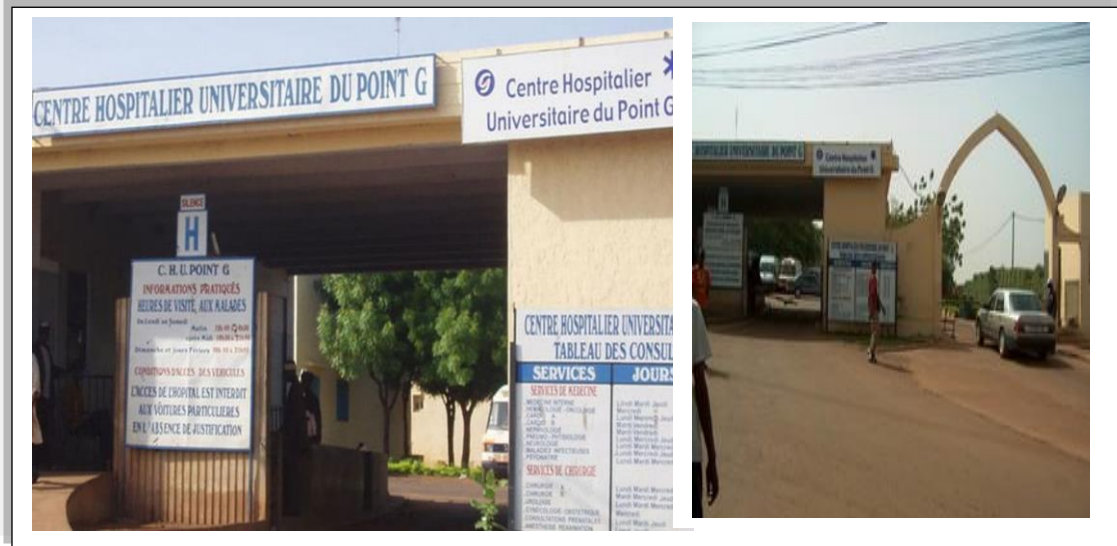
Figure 6 : Porte d'entrée du CHU du Point G à droite, la sortie à gauche
