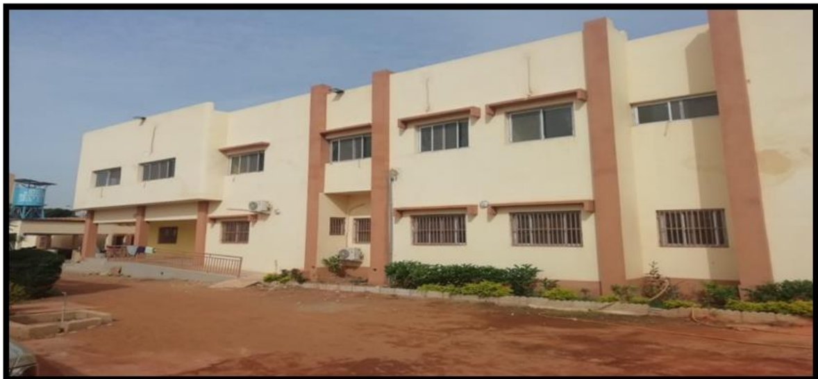
Figure 8: Vue photographique de la façade du service de pédiatrie.
