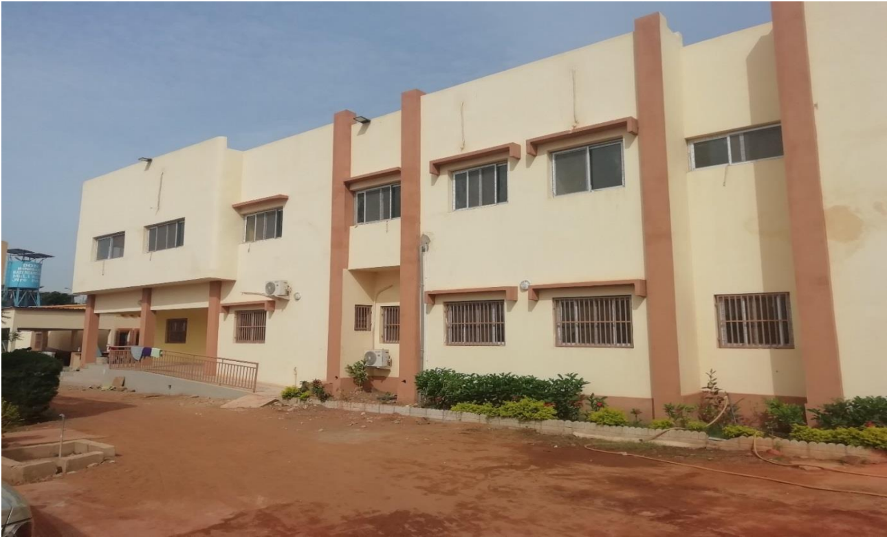
Fig.4 : Vue photographique de la façade principale du service de pédiatrie.
