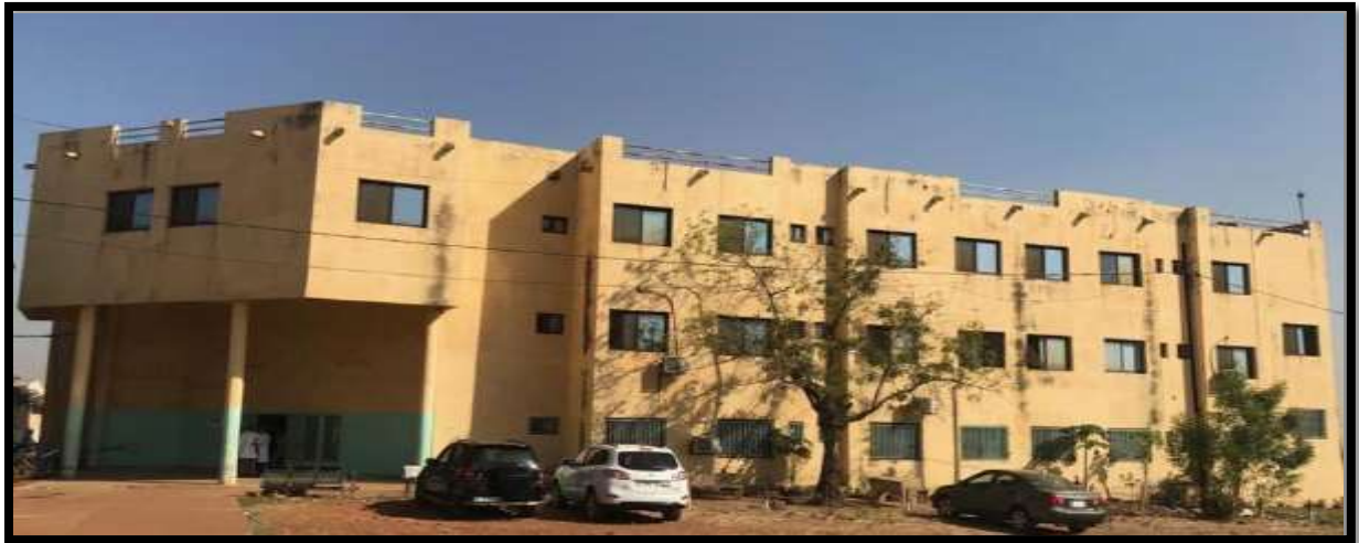
Figure 15 : vue d'ensemble de face convexe - Médecine Interne côté Sud au bord de la route
