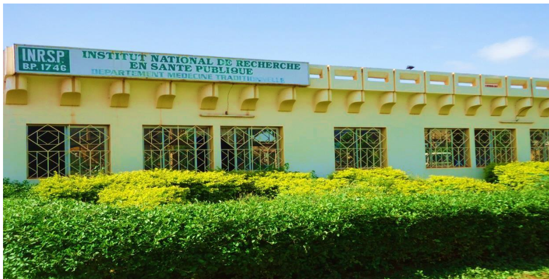
Figure 9: Photo d'une façade du Département Médecine Traditionnelle (DMT) [Diallo, 2018]
