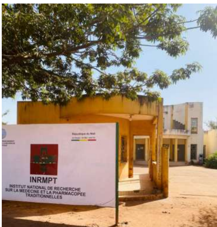
Figure 7. Photo d'une façade de l'Institut National de Recherche sur la Médecine et la Pharmacopée Traditionnelles (INRMPT) photo prise par Abdou BA 2025.
