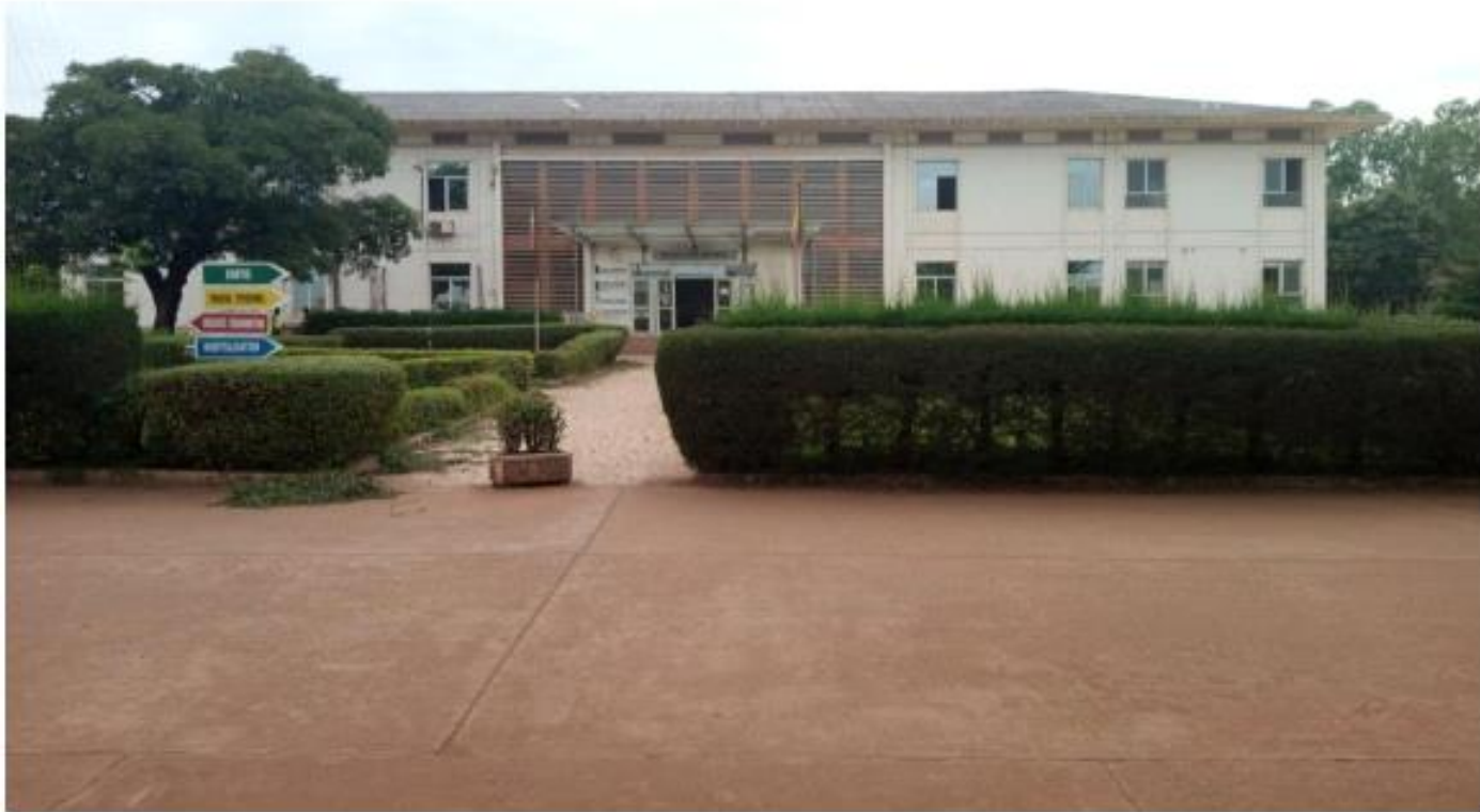
Figure 12 : vue de face du bureau d'entrée de l'hôpital du Mali (Source : image personnelle)
