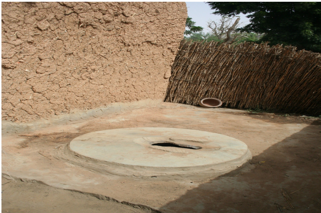
Photo n°8 : Latrine à dalle Sanplat
