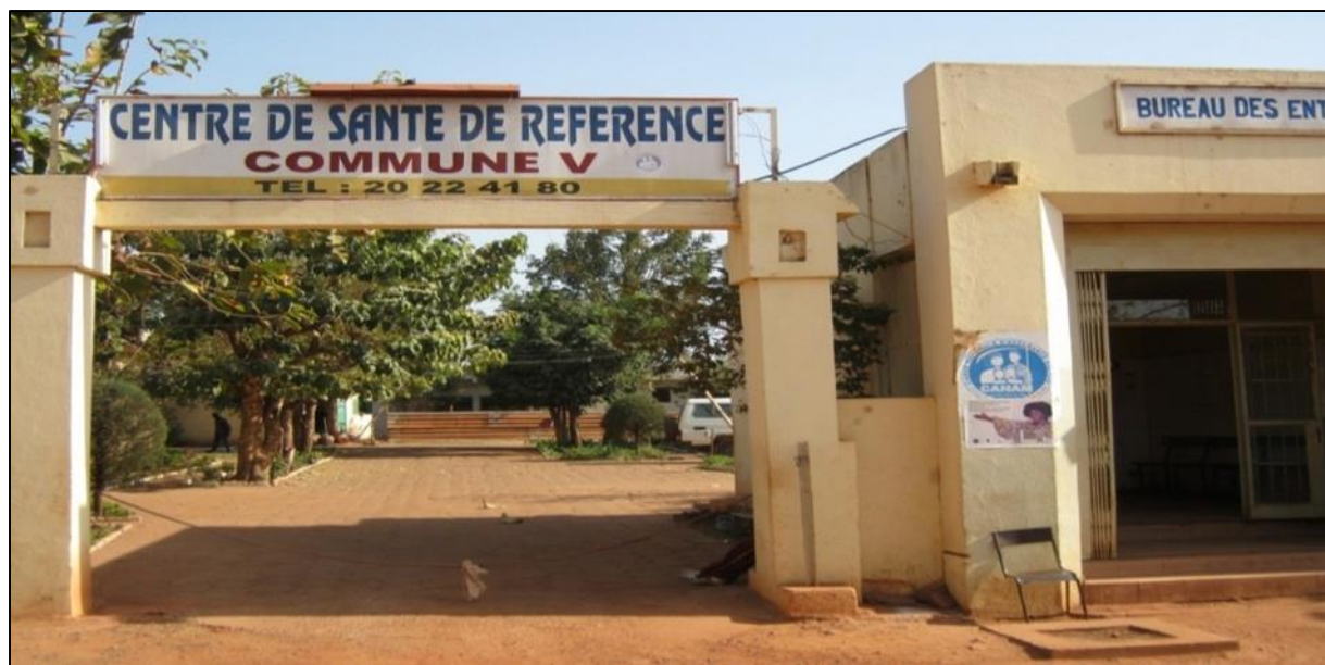
Figure 2 : Vue photographique de la façade principale du centre de santé de référence de la commune V du district de Bamako
