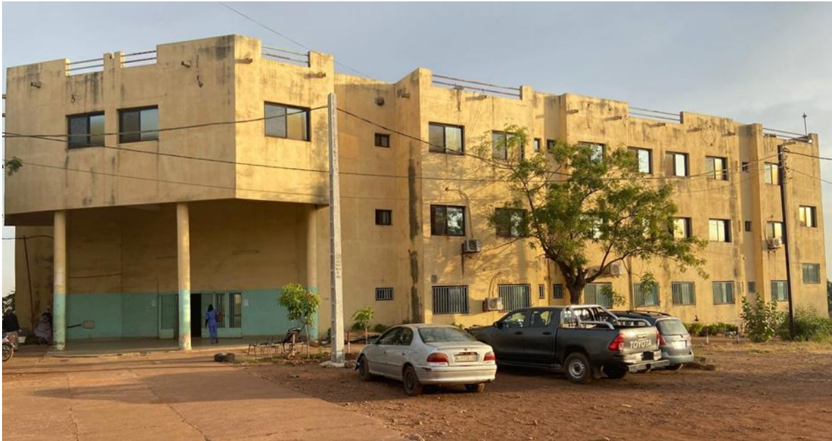
Figure 16 : Vue d'ensemble de face convexe - Médecine Interne côté Sud au bord de la route
