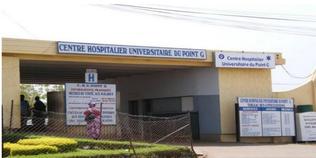
Figure 17: Entrée du CHU Point G.
