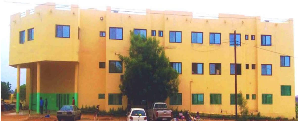
Photo 1 : Vue d'ensemble de face convexe – Médecine Interne côté sud au bord de la route
