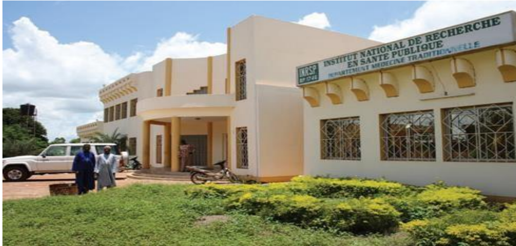
Figure 2: Photo de la façade du Département de Médecine Traditionnelle
